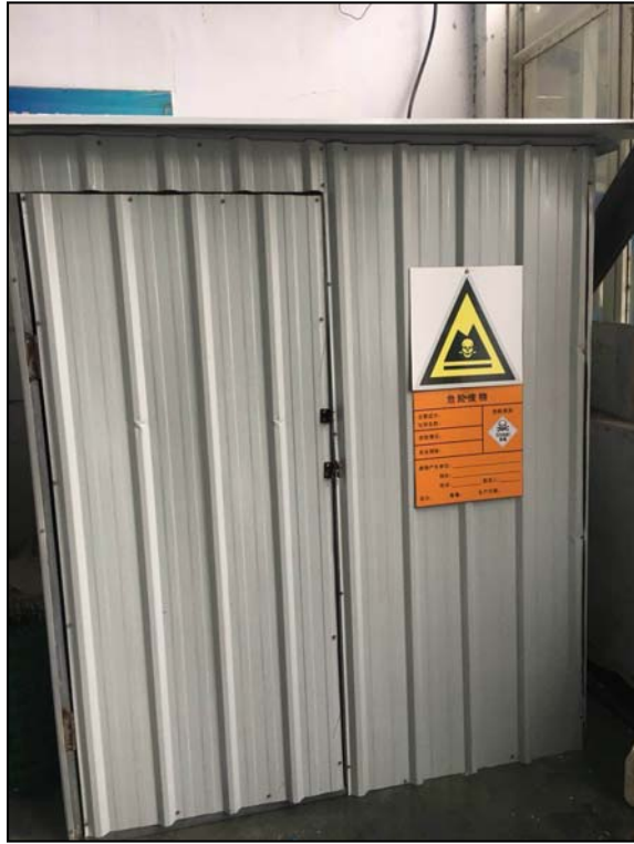
危险废物暂存间
